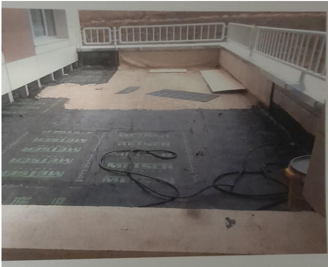
T3/5 önündeki jeomembran (PVC) üstü bitüm kaplama
