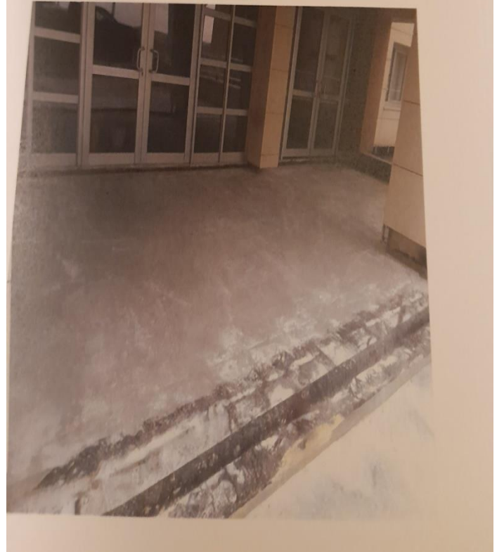
T3/2 çakıllı alanda pvc üstü ziftli malzeme ile yapılan kaplama
