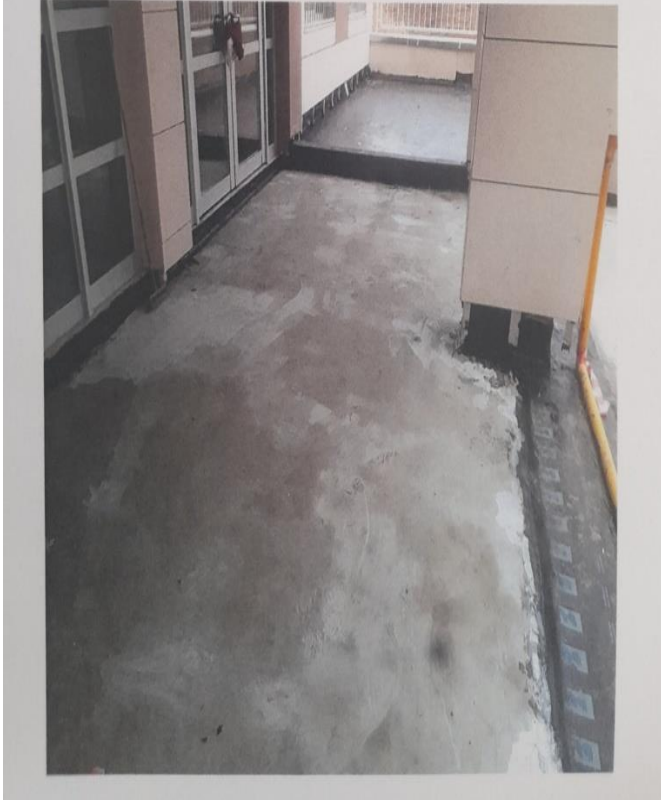
T3/4 pvc üstü ziftli malzeme ile yapılan kaplama
